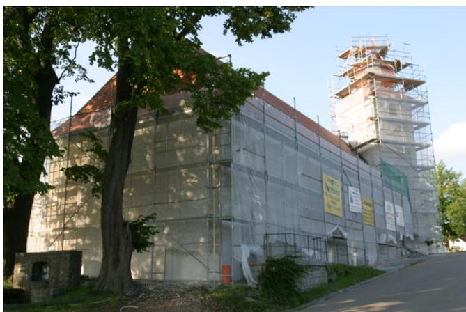
Erneuert werden musste auch der Außenputz. Dazu kamen der Vorbau am Haupteingang, der neue Dachstuhl für den Turm und die Dachverkleidung mit Kupferblech. Besonderen Wert legt der Kirchenpfleger dabei auf die Feststellung, „dass beide Eingänge behindertengerecht sind“. Für die Gesamtmaßnahme einschließlich der Restaurierung des Turmkreuzes und der Turmuhr sowie der Erneuerung des Stundenschlagwerks investierte die
